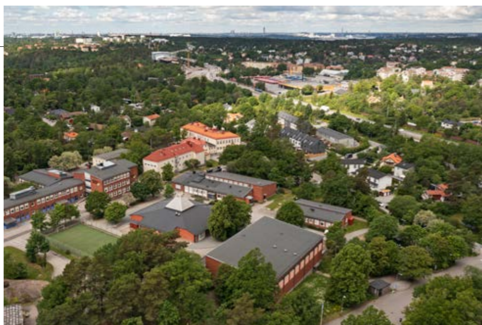
Figur 41. Björknässkolan sedd från sydost.
